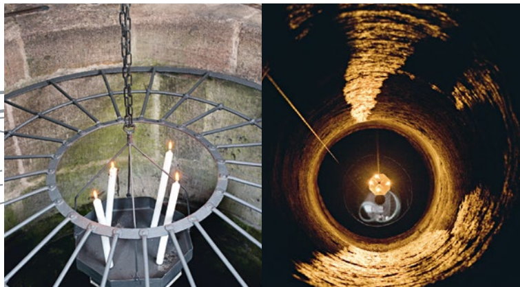
Blick in den Schacht des Tiefen Brunnens
