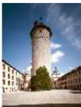
WüFg.I, Innenhof mit Bergfried, Marienkirche und Sonnenturm, DE002012, BSV-
