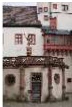
WüFg.I, Brunnenbau, DI016021, BSV-
