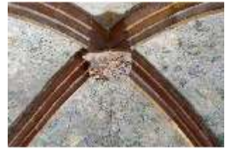
WüFg.II, Vorzimmer (R.9), Erker, Gewölbe mit Schlussstein, DI000821, BSV-
