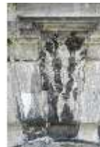
WüFg.I, Fassadendetail, Keilstein?, DI000794, BSV-
