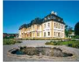
Vh.I, Westfassade, DE001540, BSV-
