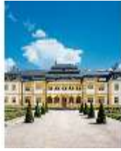
Vh.I, Westfassade, DE001287, BSV
