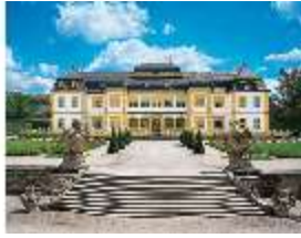
Vh.I, Hauptfassade, Westtreppe zum Parterre, DE002494, BSV
