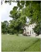
SLH.V, Steiger in den Bäumen an der Ostfassade, DI006397, BSV-
