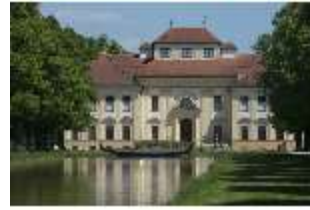
SLH.I, Fassade und Mittelkanal, DI014794, BSV
