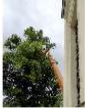
SLH.V, Steiger in den Bäumen an der Ostfassade, DI006399, BSV-
