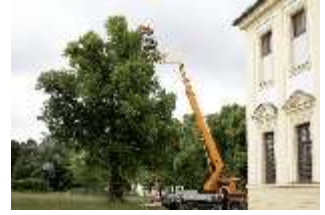
SLH.V, Steiger in den Bäumen an der Ostfassade, DI006402, BSV-
