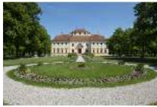
SLH.I, Fassade und Parterre, DI014797, BSV
