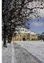
SLH.V, Blick zur Westfassade verschneit im Winter, DI013822, BSV-
