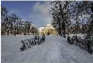
SLH.V, Blick zur Westfassade verschneit im Winter, DI013813, BSV-
