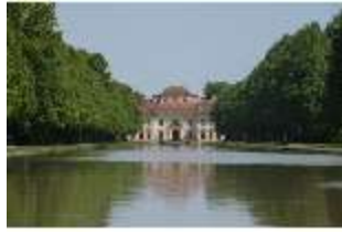
SLH.I, Fassade und Mittelkanal, DI014793, BSV
