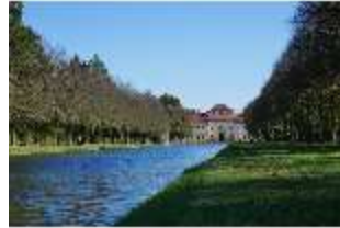
SLH.V, Blick auf die Westfassade, DI014079, BSV-
