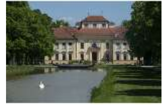
SLH.I, Fassade und Mittelkanal, DI014795, BSV
