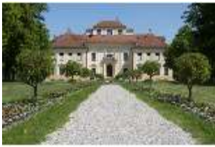
SLH.I, Fassade und Parterre, DI014796, BSV
