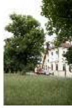
SLH.V, Steiger in den Bäumen an der Ostfassade, DI006401, BSV-
