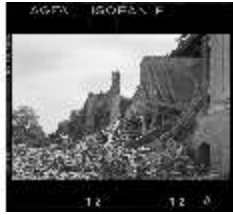
SAS.I, Kriegszerstört Ostseite (Detail), DE000348, BSV
