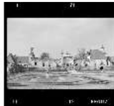
SAS.I, Kriegszerstörte Ostfassade, DE000331, BSV
