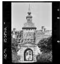
SAS.I, Kriegszerstörte Uhrenturm im Wiederaufbau, DE000343, BSV
