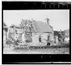
SAS.I, Kriegszerstörte Ostfassade (Detail), DE000319, BSV
