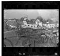
SAS.I, Kriegszerstörte Ostfassade, DE000327, BSV
