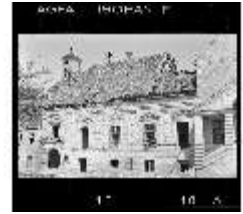
SAS.I, Kriegszerstörte Westseite, Nordteil, DE000346, BSV
