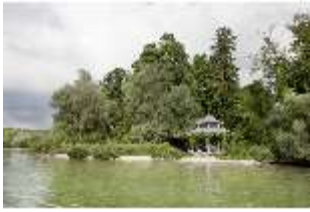
Ro.I, Pavillon im Süd-Osten der Insel vom Starnberger See aus, DI006635, BSV
