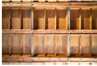
Ro.II, Kassettenplafond, Gartensaal, R. 6, DI035051, BSV-
