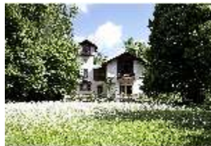
Ro.I, Südfassade des Casinos, DI010127, BSV-
