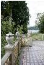
Ro.I, Casino, gr. Terrasse, Balustrade mit Vasen, DI006651, BSV
