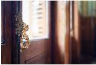
Ro.II, Türgriff, Detail, Südwall, Gartensaal, R. 6, DI035058, BSV-
