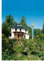
Ro.I, Casino von Osten mit Glassäule, DE001118, BSV
