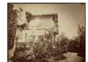
Ro.I, Südwestseite des Casinos (J.Albert), DI009149, BSV-
