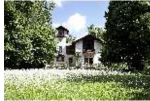
Ro.I, Südfassade des Casinos, DI010127, BSV-
