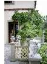
Ro.I, Casino, gr. Terrasse, Balustrade mit Vasen, DI006648, BSV
