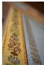
Ro.II, Wandgestaltung, Rahmung, Speisesaal, 1. OG, R. 7, DI035036, BSV-
