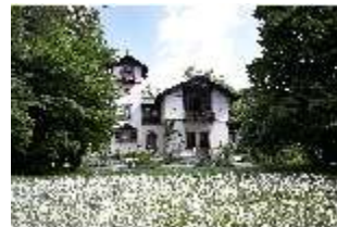
Ro.V, Südfassade des Casinos, DI010124, BSV-
