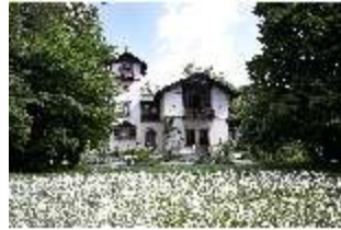
Ro.V, Südfassade des Casinos, DI010124, BSV-
