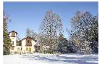
Ro.V, Südfassade des Casinos, Winter, DI007441, BSV-
