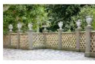
Ro.I, Casino, große Terrasse, Balustrade mit Vasen auf der Südseite, DI006645, BSV
