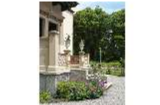
Ro.I, Südseite Casino, Treppenaufgang, DE004460, BSV
