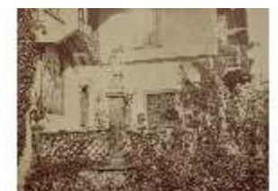
Ro.I, Südwestseite des Casinos (J.Albert), DI009148, BSV-
