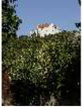
RieRo.I, Ostfassade, DI014826, BSV-
