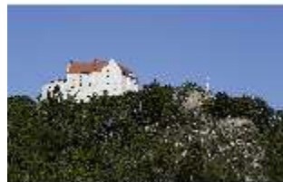
RieRo.I, Ostfassade, DI014831, BSV-
