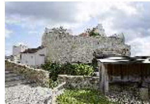
RieRo.I, Südfassade, DI014838, BSV-
