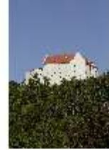
RieRo.I, Ostfassade, DI014829, BSV-
