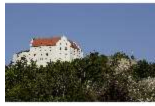
RieRo.I, Ostfassade, DI014828, BSV-
