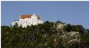
RieRo.I, Ostfassade, DI014830, BSV-
