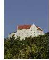
RieRo.I, Ostfassade, DI014825, BSV-
