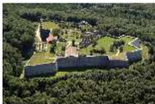
RoFg.I, Luftaufnahme, Blick von Westen, DI000218, BSV
