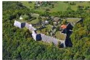
RoFg.I, Luftaufnahme, Blick von Osten, DI000069, BSV
