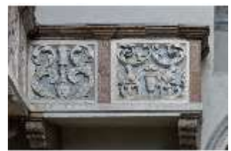
ND.II, Schlosskapelle, Emporenbrüstung, DI002937, BSV
