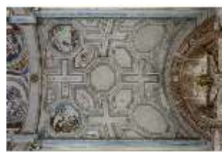
ND.II, Schlosskapelle, Gewölbe über dem Altar, DI002922, BSV
