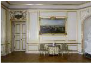
ResMü.II, Kurfürstenzimmer, Vorzimmer, R. 23, nach der Rest., DI038716, BSV
