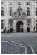
ResMü.I, Westfassade, Nordportal, Gesamtansicht, DI033777, BSV
