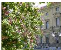
ResMü.I, Nordfassade (Festsaalbau) mit Kastanienbaum, DI006175, BSV
