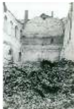
ResMü.II, Gardemeuble (Depot), Kohleraum, DE004274, BSV
