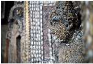
ResMü.II, Detail Felsenbrunnenanlage, Grottenhof, R. 6, DI028804, RSV-
