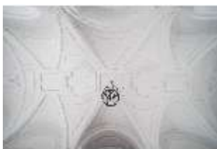
ResMü.II, Decke, Breite Treppe, EG, DI032812, BSV-
