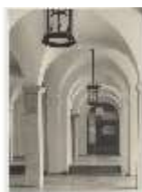
ResMü.II, Herkulesaal, Foyer, EG, nach Fertigstellung, DE004815, BSV
