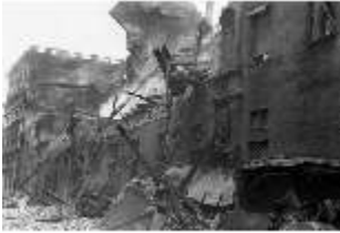
ResMü.II, Westfassade Residenz, Kriegszerstörung, DE003305, BSV
