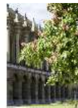
ResMü.I, Nordfassade (Festsaalbau), DI006181, BSV
