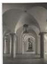
ResMü.II, Herkulesaal, Foyer, EG, nach Fertigstellung, DE004816, BSV
