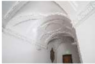
ResMü.II, Breite Treppe, Decke, DI032815, BSV-
