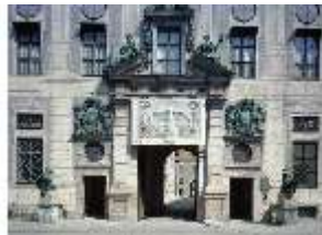
ResMü.I, Westfassade, südliches Portal, DE000736, BSV-
