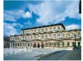
ResMü.I, Königsbau, Hauptfassade, DE004053, BSV-
