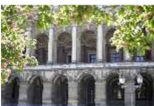
ResMü.I, Nordfassade (Festsaalbau), DI006189, BSV
