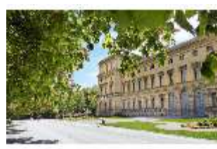
ResMü.I, Nordfassade (Festsaalbau), DI006169, BSV
