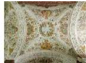
ResMü.II, Kaisertreppe, Deckenmalerei mit Stuckornamenten, DI026802, BSV
