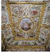
ResMü.II, Steinzimmer, R. 107, Decke, DE000283, BSV-
