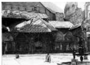
ResMü.I, Grottenhof, Zerstörungszustand 1953/1954, DE000965, BSV-
