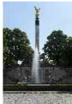
MüMa.V, Terrassenanlage mit Friedensengel, DI009345, BSV-
