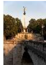
MüMa.V, Terrassenanlage mit Friedensengel, DI009346, BSV-
