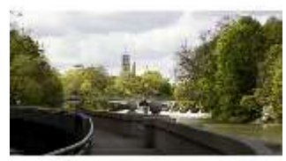
MüMa.V, Blick auf Kabelsteg, DI006699, BSV-
