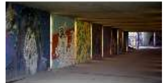
MüMa.V, Fußgängerunterführung Luitpoldbrücke, DI006685, BSV-
