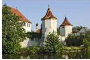
Blu.I, Ansicht von Südosten, DI003602, BSV
