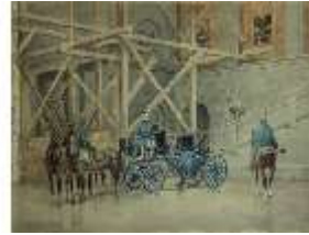
BSV-Grafikslg.III,G, Ludwig II.auf der Baustelle Neuschwanstein, LIIMus., Neusch. DI024361 BSV
