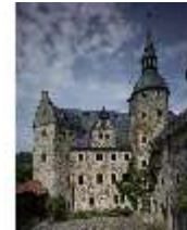
LauBg.I, Innenhof, Blick von SW, DI000290, BSV
