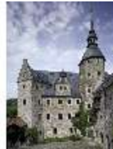
LauBg.I, Innenhof, Blick von SW, DI000289, BSV
