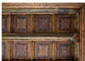
LauBg.II, Holzdecke, Detail (R.13), DI000323, BSV
