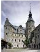
LauBg.I, Innenhof, Blick von SW, DI000288, BSV
