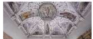
LaRes.II, Venuszimmer, Gewölbe, R.20, DI005358, BSV
