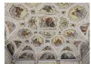
LaRes.II, Göttersaal, Gewölbmalereien, R.16, DI005310, BSV
