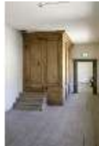
LaRes.II, Mezzanin über dem Kapellengang, Betstüberl, DI005285, BSV
