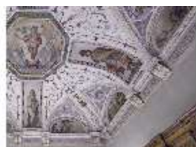
LaRes.II, Venuszimmer, Gewölbe, R.20, DI005362, BSV
