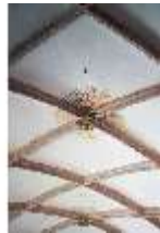
LaT.II, Decke mit Netzrippengewölbe, Burgkapelle St. Georg, R. 4, DI035453, BSV-
