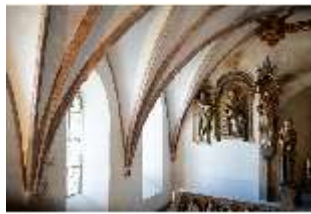
LaT.II, Spätgotisches Netzrippengewölbe, Burgkapelle St. Georg, R. 4, DI035152, BSV-
