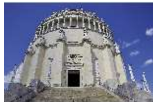
KeBf.I, Außenansicht Süd- Osten, DI014262, BSV-
