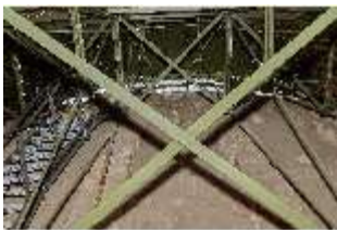
KeBf.II, Dachboden, DI014213, BSV-
