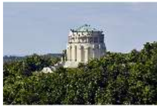
KeBf.I, Außenansicht Nord- Osten, DI014245, BSV-
