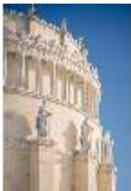
KeBf.I, Stebepfeiler mit Kalksteinfiguren an der Außenfassade, DI013621, RSV-
