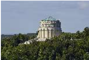
KeBf.I, Außenansicht Nord- Osten, DI014244, BSV-
