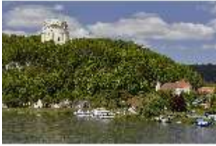
KeBf.I, Außenansicht von Süden, DI014281, BSV-
