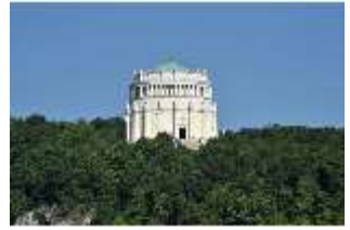
KeBf.I, Außenansicht, DI011074, BSV-
