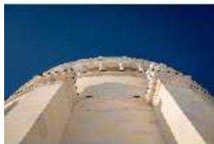
KeBf.I, Blick die Außenfassade hoch, DI013607, BSV-
