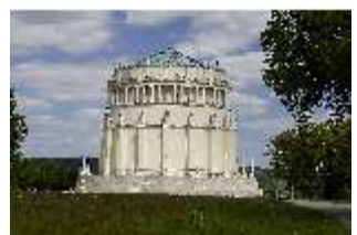
KeBf.I, Außenansicht Süd- Westen, DI014272, BSV-
