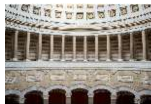
KeBf.II, Säulengalerie, DI013643, BSV-
