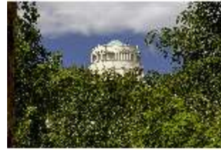
KeBf.I, Außenansicht von Süden, DI014279, BSV-
