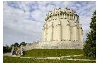
KeBf.I, Außenansicht Nord- Osten, DI014247, BSV-
