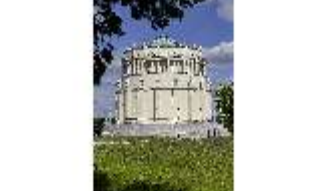
KeBf.I, Außenansicht Süd- Westen, DI014276, BSV-
