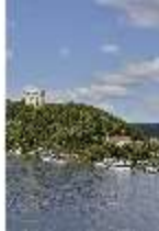
KeBf.I, Außenansicht von Süden, DI014286, BSV-
