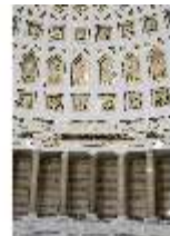
KeBf.II, Säulengalerie, DI014463, BSV-
