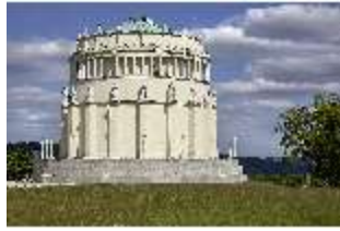
KeBf.I, Außenansicht Süd-Westen, DI014278, BSV-
