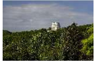
KeBf.I, Außenansicht Nord- Osten, DI014243, BSV-
