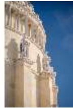
KeBf.I, Stebepfeiler mit Kalksteinfiguren an der Außenfassade, DI013619, RSV-
