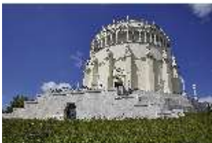
KeBf.I, Außenansicht Süd- Osten, DI014260, BSV-
