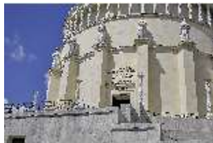
KeBf.I, Außenansicht Süd- Osten, DI014261, BSV-
