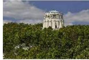
KeBf.I, Außenansicht von Süden, DI014283, BSV-
