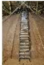
KeBf.II, Dachboden, DI014211, BSV-
