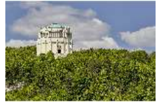
KeBf.I, Außenansicht von Süden, DI014280, BSV-
