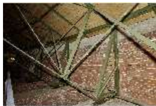
KeBf.II, Dachboden, DI014214, BSV-
