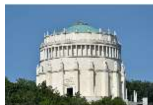
KeBf.I, Außenfassade, Eingangsseite, DI011076, BSV-
