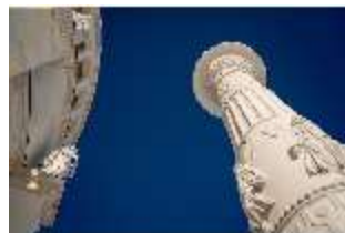
KeBf.I, Blick die Außenfassade hoch, DI013610, BSV-
