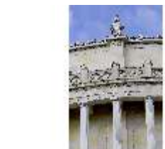
KeBf.I, Blick zur Trophäe auf dem Dach, DI014235, BSV-
