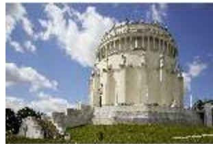
KeBf.I, Außenansicht Nord- Osten, DI014246, BSV-
