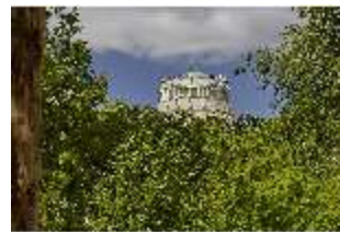
KeBf.I, Südfassade, DI014462, BSV-
