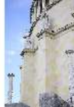
KeBf.I, Außenansicht von Süden (Detail), DI014287, BSV-
