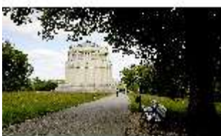
KeBf.I, Außenansicht Süd- Westen, DI014273, BSV-
