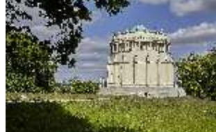
KeBf.I, Außenansicht Süd- Westen, DI014275, BSV-
