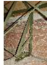
KeBf.II, Dachboden, DI014212, BSV-
