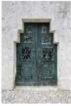
KeBf.I, Bronzeportal zu den Kellergewölben, DI014251, BSV-
