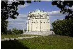
KeBf.I, Außenansicht Süd-Westen, DI014277, BSV-
