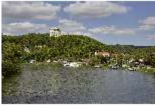
KeBf.I, Außenansicht von Süden, DI014285, BSV-
