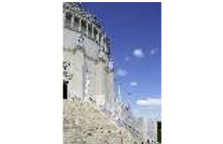
KeBf.I, Außenansicht Süd- Osten, DI014265, BSV-
