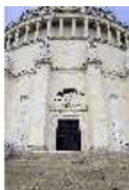
KeBf.I, Außenansicht Süd- Osten, DI014267, BSV-
