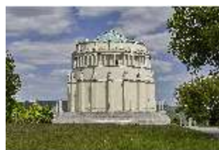
KeBf.I, Außenansicht Süd- Westen, DI014271, BSV-
