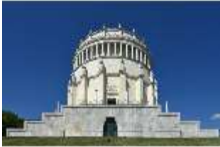
KeBf.I, Aussenansicht mit Unterbau, Eingangsseite, DI011097, BSV-
