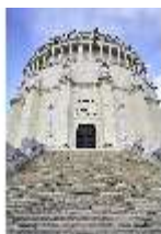
KeBf.I, Außenansicht Süd- Osten, DI014266, BSV-
