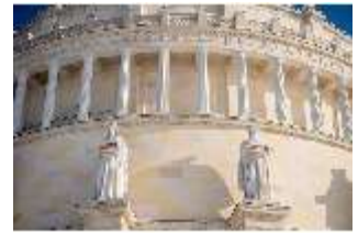
KeBf.I, Stebepfeiler mit Kalksteinfiguren an der Außenfassade, DI013620, RSV-
