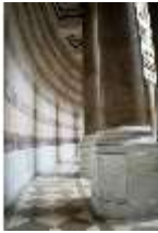
KeBf.II, Säulengalerie, DI013641, BSV-
