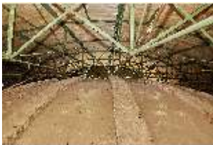
KeBf.II, Dachboden, DI014209, BSV-
