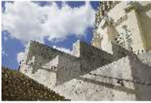
KeBf.I, Freitreppe, DI014268, BSV-
