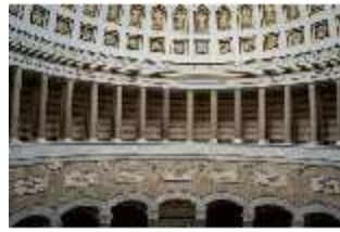
KeBf.II, Säulengalerie, DI013639, BSV-
