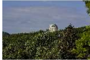
KeBf.I, Außenansicht Nord- Osten, DI014242, BSV-
