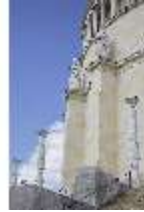
KeBf.I, Seitenansicht der Fassade, DI014270, BSV-
