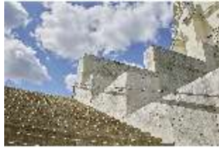
KeBf.I, Freitreppe, DI014269, BSV-
