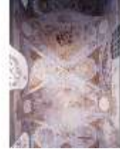
HöS.II, Schloßkapelle, Gewölbe, DE001931, BSV-
