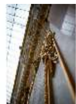
HchNS.II, Detail Wandgestaltung Prunktreppe, R. 3, DI020476, BSV-
