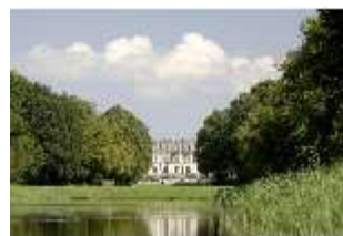
HchNS.V, Westfassade vom Kanal aus, DI006205, BSV
