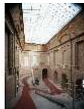
HchNS.II, Nördliches Treppenhaus (R.20), DE001984, BSV-
