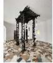
HchNS.II, Technikraum "Tischlein deck dich", DI019512, BSV-
