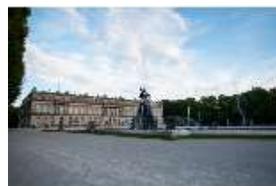
HchNS.I, Gartenfassade, Westfassade, DI020454, BSV-
