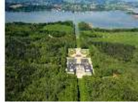
HchNS.I, Luftaufnahme, Blick von Osten, DI003263, BSV-
