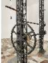
HchNS.II, Technikraum "Tischlein deck dich", DI019513, BSV-
