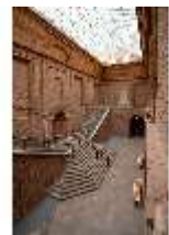
HchNS.II, Nördliches Treppenhaus (R. 20), DI020500, BSV-
