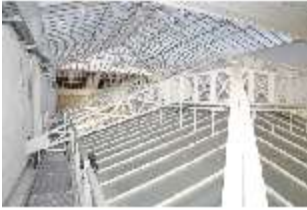
HchNS.II, Dachkonstruktion Treppenhaus, DI023682, BSV-
