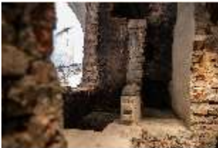
HchAS.II, Inseldom, Sanierungsarbeiten, DI038624, BSV-
