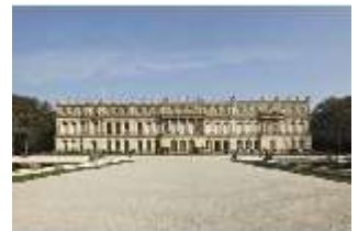
HchNS.I, Gartenfassade, DI003259, BSV-
