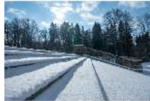
HchNS.V, Treppe, Westliche Gartenachse, DI018821, BSV
