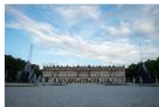
HchNS.I, Gartenfassade, Westfassade, DI020458, BSV-
