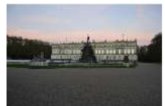
HchNS.I, Westfassade mit Fortuna-Brunnen, DI006005, BSV-
