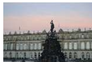
HchNS.I, Westfassade mit Fortuna-Brunnen, DI006004, BSV-
