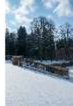
HchNS.V, Treppe, Westliche Gartenachse, DI018805, BSV
