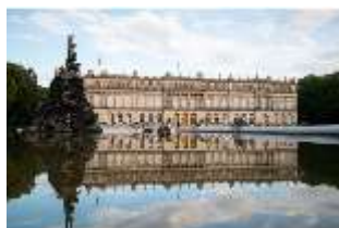
HchNS.I, Gartenfassade, Westfassade, DI020453, BSV-
