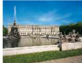
HchNS.I, Westfassade mit Famabrunnen, DE001112, BSV
