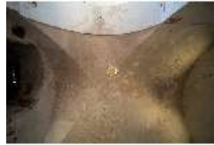
HchAS.II, Inseldom, Gewölbe, DI038646, BSV-
