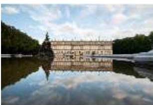
HchNS.I, Gartenfassade, Westfassade, DI020452, BSV-
