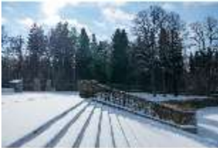
HchNS.V, Treppe, Westliche Gartenachse, DI018807, BSV
