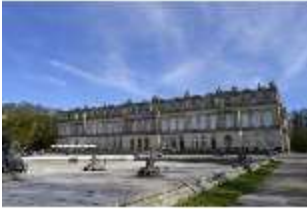
HchNS.I, Westfassade und südliches Bassin, DI005983, BSV-
