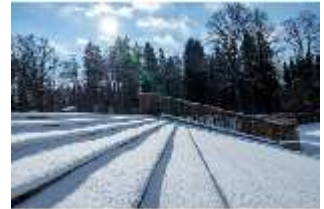
HchNS.V, Treppe, Westliche Gartenachse, DI018824, BSV
