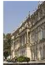
HchNS.I, Gartenfassade, DI003258, BSV-
