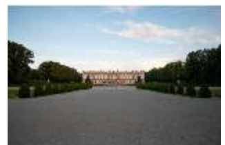
HchNS.I, Gartenfassade, Westfassade, DI020451, BSV-
