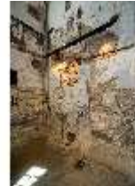
HchAS.II, Inseldom, Sanierungsarbeiten, DI038645, BSV-
