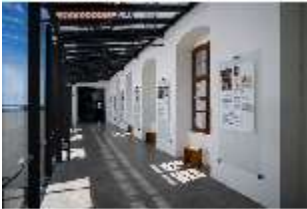
HchAS.II, Verbindungsgang, DI038555, BSV-
