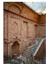
HchNS.II, Nördliches Treppenhaus, R. 20, DI020504, BSV-
