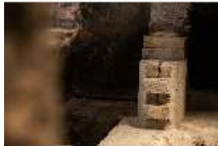
HchAS.II, Inseldom, Sanierungsarbeiten, DI038625, BSV-
