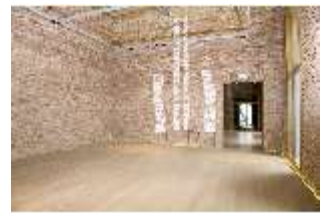
HchNS.II, Veranstaltungsräume (Rohbau), DI009729, BSV-
