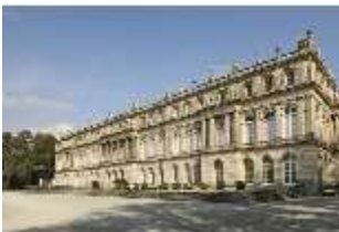
HchNS.I, Gartenfassade, DI003262, BSV-
