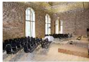
HchNS.II, Veranstaltungsräume (Rohbau), DI009728, BSV-
