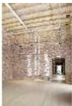
HchNS.II, Veranstaltungsräume (Rohbau), DI009730, BSV-
