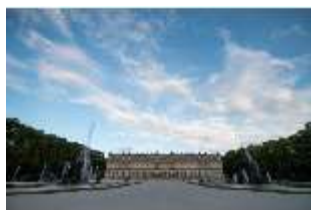
HchNS.I, Gartenfassade, Westfassade, DI020457, BSV-
