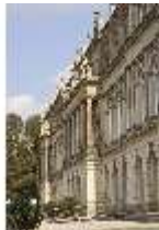
HchNS.I, Gartenfassade, DI003257, BSV-
