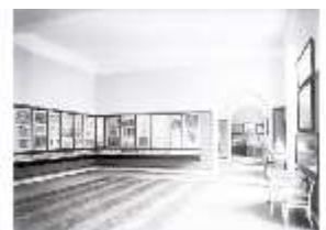
LIIMus.II, Raumaufnahme, Saal IV, Zustand 1926, DE004287, BSV-
