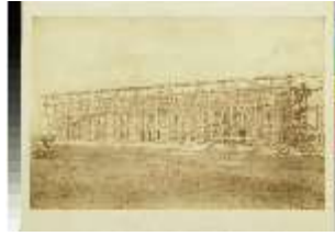
LIIMus.III, Schloss Herrenchiemsee Baustelle HCHNS, DI019102, BSV-
