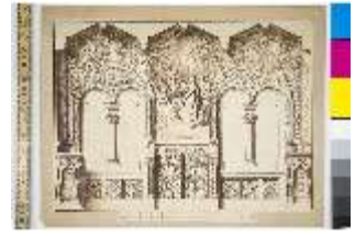
LIIMus.IV, Speisezimmer, Fensterwand, Neusch., DI031495, BSV-
