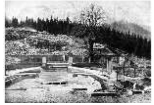
LIIMus.III, Foto Baustelle Linderhof, Lin., DE002499, BSV-
