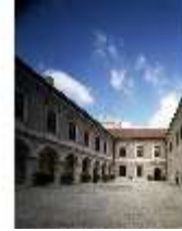
EiW.I, Innenhof, Gemmingenbau, DE003439, BSV-
