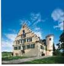
CoR.I, Ansicht von Nordwesten, DE000984, BSV
