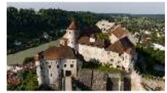
Bgh.I, Luftaufnahme, Blick auf die Hauptburg (AF 1-8), DI034504, BSV-
