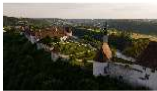
Bgh.I, Luftaufnahme, Blick in den vierten Vorhof nach Westen, DI034512, BSV-
