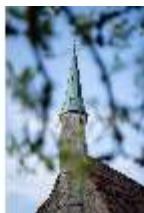
Bgh.I, Kirchturmspitze der Äußeren Burgkapelle St. Maria, DI034768, BSV-
