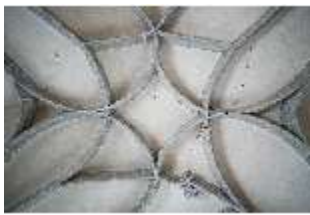
Bgh.II, Äußere Burgkapelle St. Maria, spätgotisches Rippengewölbe, DI034710, BSV-
