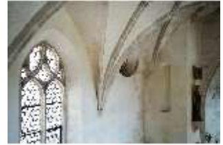
Bgh.II, Innere Burgkapelle St. Elisabeth, Fenster und Gewölbe, DI034603, BSV-
