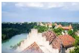
Bgh.I, Blick von der Aussichtsplattform des Palas auf die Burg, DI034678, BSV-
