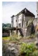
Bgh.I, Hauptburg, Blick auf die Brücke über den Halsgraben, DI034537, BSV-
