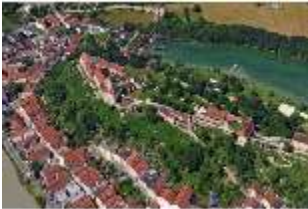
Bgh.I, Hauptburg, Luftaufnahme von Nordosten, DI003269, BSV
