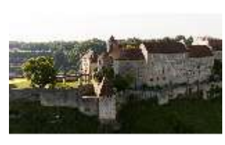
Bgh.I, Luftaufnahme, Blick auf die Hauptburg Richtung Südosten, DI034502, BSV-
