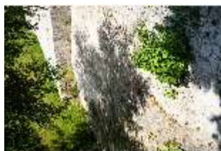
Bgh.I, Hauptburg, Blick auf die Burgmauer von oben, DI034538, BSV-
