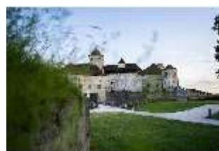
Bgh.I, Burg und Schildmauer vom ersten Vorhof aus gesehen, DI034780, BSV-
