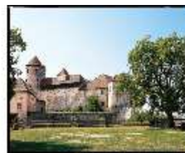
Bgh.I, Hauptburg mit Bergfried und Schildmauer, DE001097, BSV-
