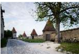
Bgh.I, Zweiter Vorhof, Drei Wachtürme, sog. Pfefferbüchsen, DI034776, BSV-
