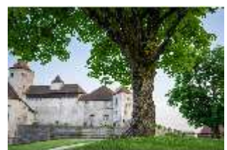
Bgh.I, Burg und Schildmauer vom ersten Vorhof aus gesehen, DI034781, BSV-
