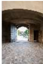
Bgh.I, Hauptburg, Torbau (AF 1), Blick durch die Pforte vom Hof aus, DI034524, BSV-
