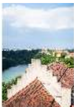
Bgh.I, Blick von der Aussichtsplattform des Palas auf die Burg, DI034677, BSV-
