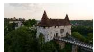
Bgh.I, Luftaufnahme, Georgstor (AF 13), Ansicht mit hölzerner Brücke, DI034491, BSV-
