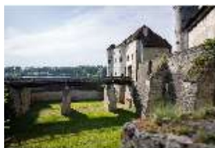
Bgh.I, Hauptburg, Blick auf die Brücke über den Halsgraben, DI034536, BSV-
