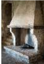
Bgh.II, Hauptburg, Palas, Erdgeschoss, Zehrgaden, Kamin, DI034753, BSV-
