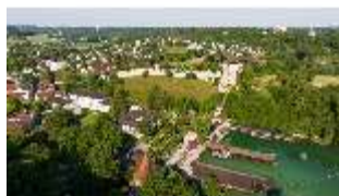
Bgh.I, Luftaufnahme, Blick nach Osten auf Burg und Außenwerk, DI034501, BSV-
