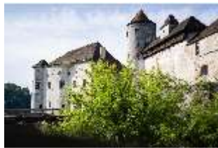
Bgh.I, Hauptburg nach Süden, Torbau, Bergfried, DI034541, BSV-
