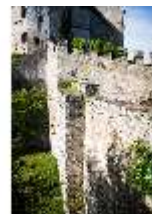
Bgh.I, Hauptburg, Blick auf die Burgmauer, DI034542, BSV-
