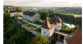
Bgh.I, Luftaufnahme, Zweiter Vorhof, Blick auf Büchsenmeisterturm, DI034512, BSV-
