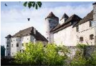
Bgh.I, Hauptburg nach Süden, Torbau und Bergfried, DI034539, BSV-
