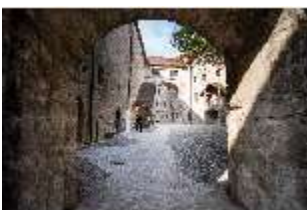
Bgh.I, Hauptburg, Blick in den Inneren Burghof (nördl. Teil), DI034522, BSV-
