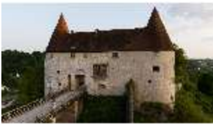
Bgh.I, Luftaufnahme, Georgstor (AF 13), Ansicht vom zweiten Vorhof, DI034488, BSV-
