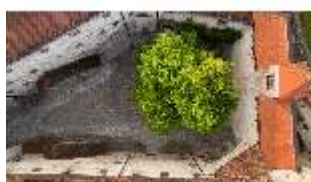
Bgh.I, Luftaufnahme, Blick von oben in den Innenhof, Hauptburg, DI034492, BSV-
