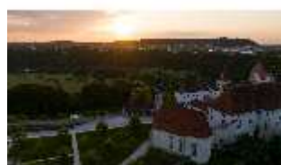
Bgh.I, Luftaufnahme, Äußere Burgkapelle, sog. Hedwigskapelle, DI034515, BSV-
