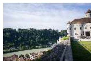
Bgh.I, Erster Vorhof, Torbau (AF 1), Blick auf die Salzach, DI034531, BSV-
