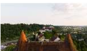
Bgh.I, Luftaufnahme, Blick über das Dach des Georgstor, DI034489, BSV-
