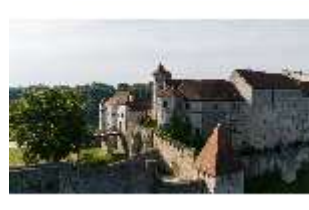
Bgh.I, Luftaufnahme, Blick auf die Hauptburg Richtung Osten, DI034503, BSV-
