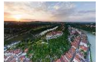
Bgh.I, Luftaufnahme, Blick nach Norden, DI034483, BSV-
