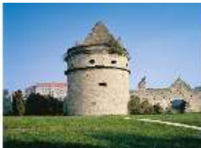
Bgh.I, Geschützturm (Pulverturm), DE002519, BSV-
