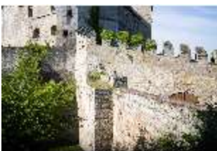
Bgh.I, Hauptburg, Blick auf die Burgmauer, DI034543, BSV-
