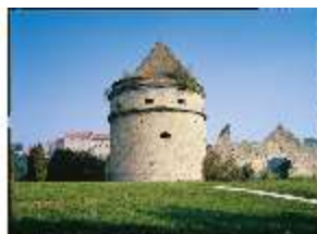
Bgh.I, Geschützturm (Pulverturm), DE002519, BSV-
