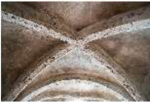
Bgh.II, Hauptburg, Palas, Erdgeschoss, Zehrgaden, Gewölbe, DI034745, BSV-
