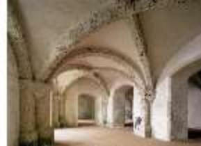
Bgh.II, Palas, Gotische Halle, DE002549, BSV-
