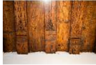
Bgh.II, Detail der Zimmerdecke, sog. Hofmeisterzimmer, R. 5, DI034650, BSV-
