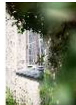
Bgh.I, Hauptburg, Oberer Zwinger (AF 6), Blick auf ein Fenster, DI034591, BSV-
