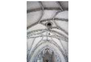
Bgh.II, Äußere Burgkapelle St. Maria, Rippengewölbe, DI034708, BSV-
