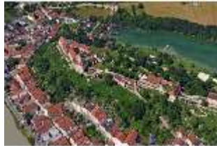
Bgh.I, Hauptburg, Luftaufnahme von Nordosten, DI003270, BSV
