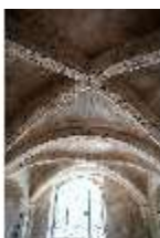
Bgh.II, Hauptburg, Palas, Erdgeschoss, Zehrgaden, DI034746, BSV-
