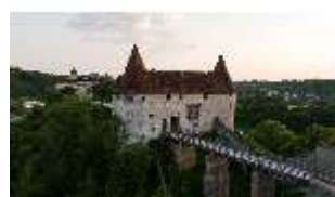
Bgh.I, Luftaufnahme, Georgstor (AF 13), Ansicht mit hölzerner Brücke, DI034490, BSV-
