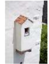
Pr.I, Südfassade, ehem. Abtritt, DI001128, BSV
