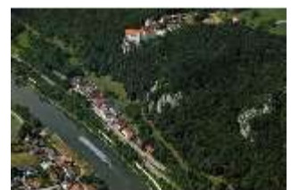
Pr.I, Burg Prunn, Luftaufnahme, DI023900, BSV
