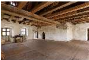
Pr.II, sog. Ritteraal mit barocker Dachkonstruktion, DI021065, BSV
