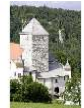
Pr.I, Torbau und Bergfried, Blick von Nordosten, DI001143, BSV
