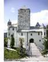
Pr.I, Nordfassade, Torbau und Bergfried, DI001140, BSV
