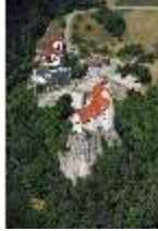
Pr.I, Burg Prunn, Luftaufnahme, DI023902, BSV
