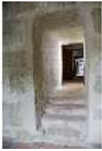
Pr.II, Bergfried, Durchgang, DI001196, BSV
