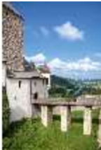
Pr.I, Teil der Brücke, im MA als Zugbrücke genutzt, DI021078, BSV
