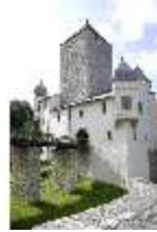
Pr.I, Nordfassade, Schrägansicht, DI001141, BSV
