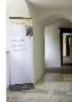
Pr.II, Obere südliche Treppenhalle, R.13, DI002332, BSV
