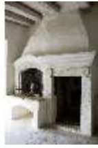
Pr.II, Wärmeküche, R.22, Kochstelle, DI002343, BSV
