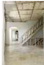
Pr.II, Treppenhaus, R.7, DI001172, BSV
