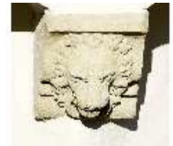
Pr.I, Erker, mittlere Konsole, Nordostseite, DI001159, BSV
