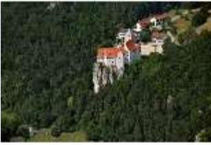
Pr.I, Burg Prunn, Luftaufnahme, DI023901, BSV
