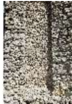
SaMB.I, Wanddetail, Morgenländischer Bau, DI014024, BSV
