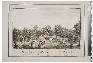
SaMB.III,G, Die Haupt-Eremiten-Gebäude zu Sanspareil, DI016432, BSV-
