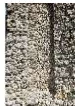
SaMB.I, Wanddetail, Morgenländischer Bau, DI014024, BSV
