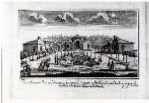
SaMB.III, Morgenländischer Bau, Joh.Th.Köppel, DE003014, BSV
