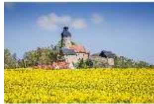
SaZwe.I, Blick auf die Südfassade, DI007790, BSV-
