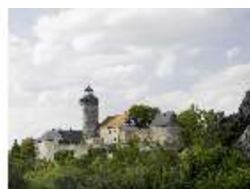
SaZwe.I, Burgfassade, Blick von Süd-Osten, DI008237, BSV-
