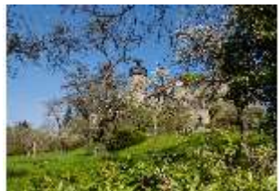
SaZwe.I, Fassade von Süd-Osten, DI007813, BSV-
