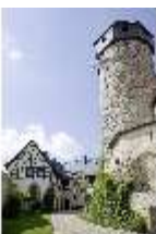
SaZwe.I, Kapellenhof, Kapellenbau und Bergfried, DI008235, BSV-
