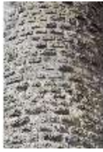
SaZwe.I, Bergfried mit Büchelquaderwerk (Detail), DI008220, BSV-
