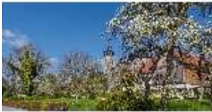
SaZwe.I, Fassade von Süd-Osten, DI007807, BSV-
