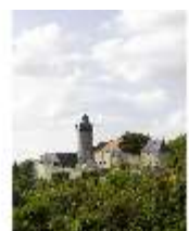
SaZwe.I, Burgfassade, Blick von Süd-Osten, DI008238, BSV-
