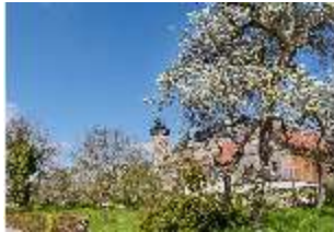
SaZwe.I, Fassade von Süd-Osten, DI007808, BSV-
