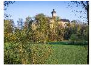
SaZwe.I, Blick auf die Nord-West Fassade, DI007931, BSV-
