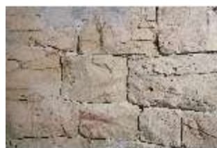
SaZwe.I, Mauerwerk im Bergfried (Detail), DI008221, BSV-
