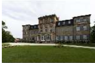
BayFa.I, Südfassade, DI017114, BSV-
