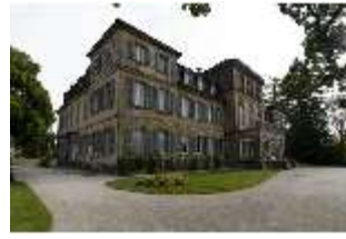
BayFa.I, Südfassade, DI017111, BSV-
