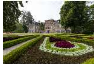
BayFa.V, Nordfassade und Teppichbeet, DI017130, BSV-
