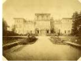
BayFa.I, Fassade, historische Aufnahme, DE001886, BSV
