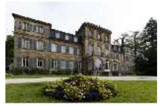
BayFa.I, Südfassade, DI017112, BSV-
