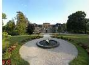
BayFa.I, Nordfassade, DI017099, BSV-
