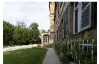
BayFa.I, Südfassade, Eingangsrailit, DI017119, BSV-
