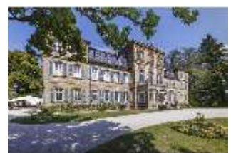
BayFa.I, Südfassade, DI002698, BSV
