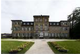
BayFa.I, Südfassade, DI017113, BSV-
