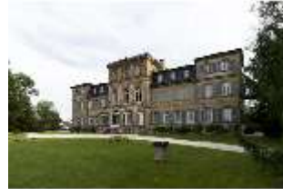
BayFa.I, Südfassade, DI017115, BSV-
