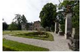
BayFa.V, Nordfassade und Teppichbeet, DI017127, BSV-
