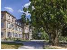
BayFa.I, Südfassade, DI002699, BSV
