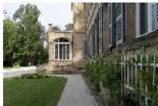
BayFa.I, Südfassade, Eingangsrailit, DI017117, BSV-
