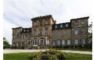
BayFa.I, Südfassade, DI017116, BSV-
