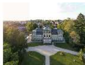
BayFa.I, Südfassade, DI017101, BSV-
