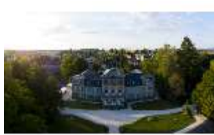
BayFa.I, Südfassade, DI017108, BSV-
