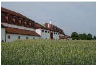
BaSee.I, Memmelsdorfer Tor (AF 3), Nordfassade, DI014058, BSV-
