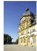
BaSee.I, seitlicher Blick auf die Fassade, DI016466, BSV
