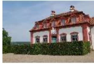
BaSee.I, Gärtnerhaus AF 1 (Nordfassade), DI014068, BSV-
