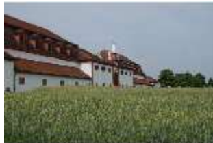
BaSee.I, Memmelsdorfer Tor (AF 3), Nordfassade, DI014058, BSV-
