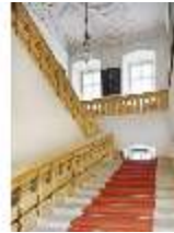
BaSee.II, Haupttreppenhaus, DI010106, BSV
