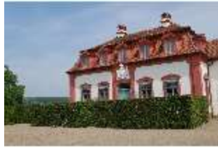
BaSee.I, Gärtnerhaus AF 1 (Nordfassade), DI014068, BSV-
