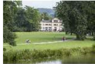
Schb.V, Wirtschaftsgebäude, Gaststätte mit Biergarten, DI006735, BSV
