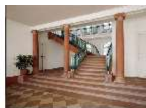
Schb.II, Vorhalle (Raum 1), DE001625, BSV-
