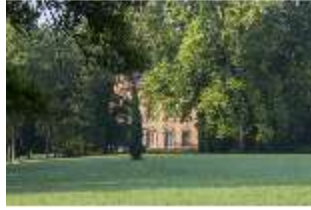
Schb.V, Nordfassade vom Park aus gesehen, DI006757, BSV
