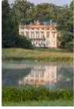
Schb.I, Hauptansicht über den Unteren See, DI006748, BSV
