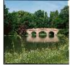
Schb.I, Rote Brücke (10), DE001204, BSV-
