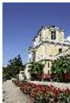
AschPomp.I, Fassade von Südosten, DI014975, BSV-
