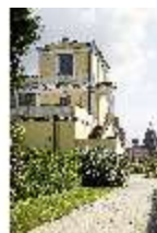
AschPomp.I, Fassade von Süd-Westen, DI014970, BSV-
