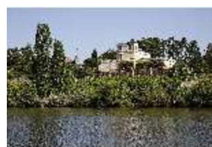
AschPomp.I, Südfassade vom Main aus, DI014981, BSV-
