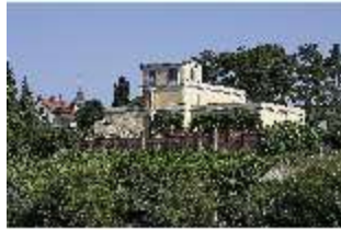
AschPomp.I, Süd- und Ostfassade, DI014990, BSV-
