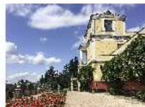
AschPomp.I, Fassade von Südosten, DI014979, BSV-
