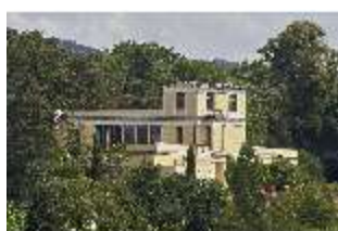
AschPomp.I, Pompejanum von Südwesten, DI014997, BSV-
