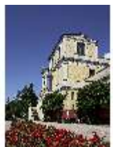
AschPomp.I, Fassade von Südosten, DI014978, BSV-
