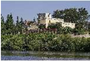
AschPomp.I, Süd- und Ostfassade, DI014989, BSV-
