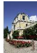
AschPomp.I, Fassade von Südosten, DI014977, BSV-
