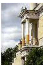
AschPomp.I, Südfassade mit Außentreppe und Aussichtspavillon, DI014974, BSV-
