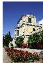
AschPomp.I, Fassade von Südosten, DI014976, BSV-
