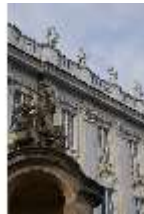
AnsRes.I, Residenz, Hauptfass. m. Wachhs./ Schilderhs., DI024129, BSV-
