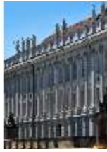
AnsRes.I, Residenz, Hauptfassade, Detail, DI000704, BSV
