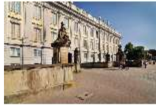
AnsRes.I, Residenz, Hauptfassade, Detail, DI000695, BSV
