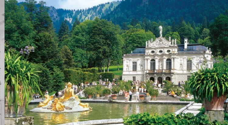
Hauptfassade von Schloss Linderhof
